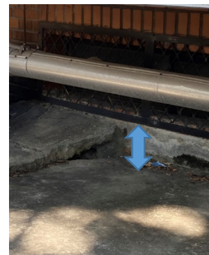
B棟臨馬路面下陷落差
