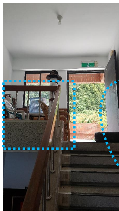
丁棟頂樓樓梯間
